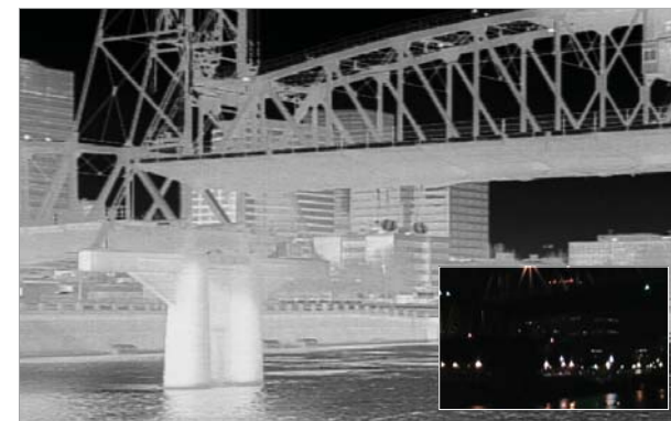
Тепловизионное изображение конструкции моста ночью и картинка, видимая невооруженным глазом (вставка)
